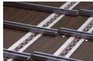
Bodenbeläge aus Holz, die bei Kontakt mit Mist den Zerstörungsprozessen nicht unterliegen
